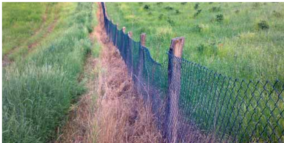
Uso dei prodotti chimici per la manutenzione delle recinzioni
