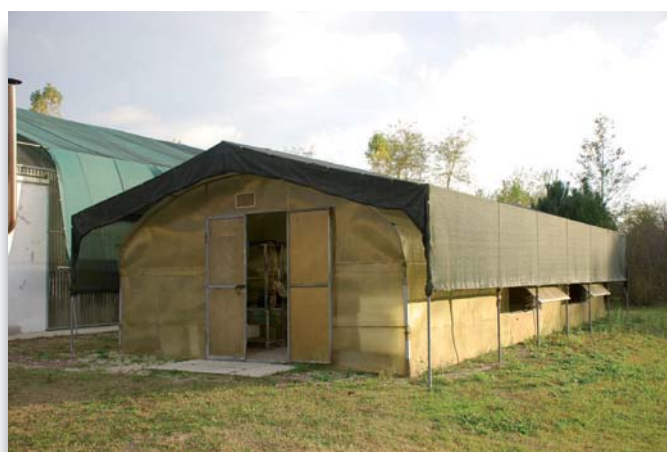
Fig. 5 Tunnel di allevamento delle giovani piante (esterno)
